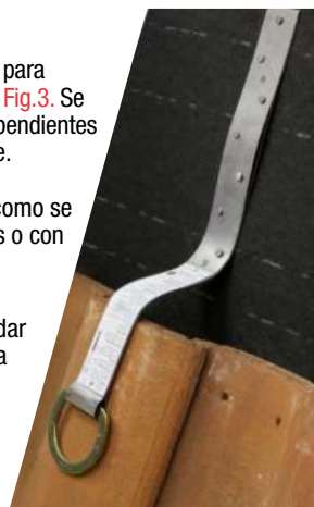
Amoldar la pata del ancla a la forma de la teja.
